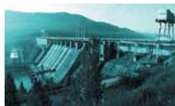
Богучанская ГЭС (Красноярский край)
