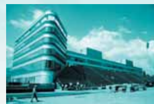
Лыжно-биатлонный комплекс «Лаура» (г. Сочи)
